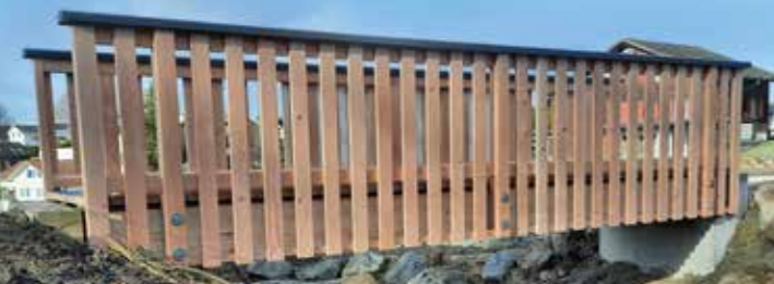
Sertelbachbrücke in Reiden
