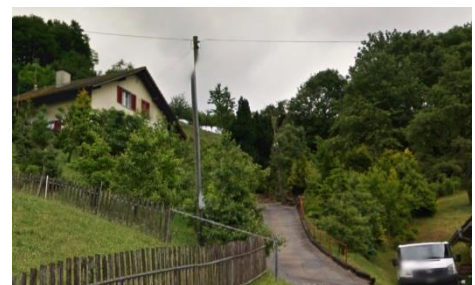
Blick Richtung Liegenschaft Hubelweg 3, Parzelle Nr. 757, GB Reiden; Quelle: Streetview, Zugriff am 29. Juni 2020
