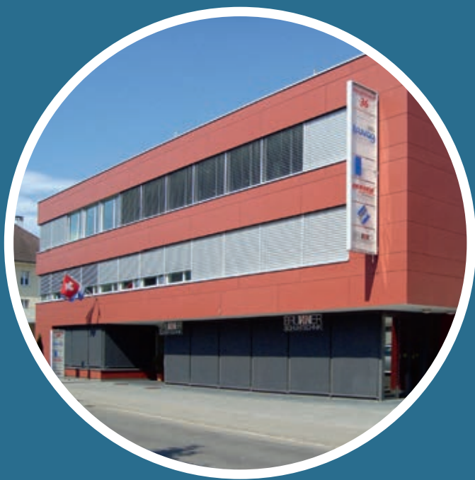
Truvag-Standort an der Hauptstrasse 36 in Reiden
