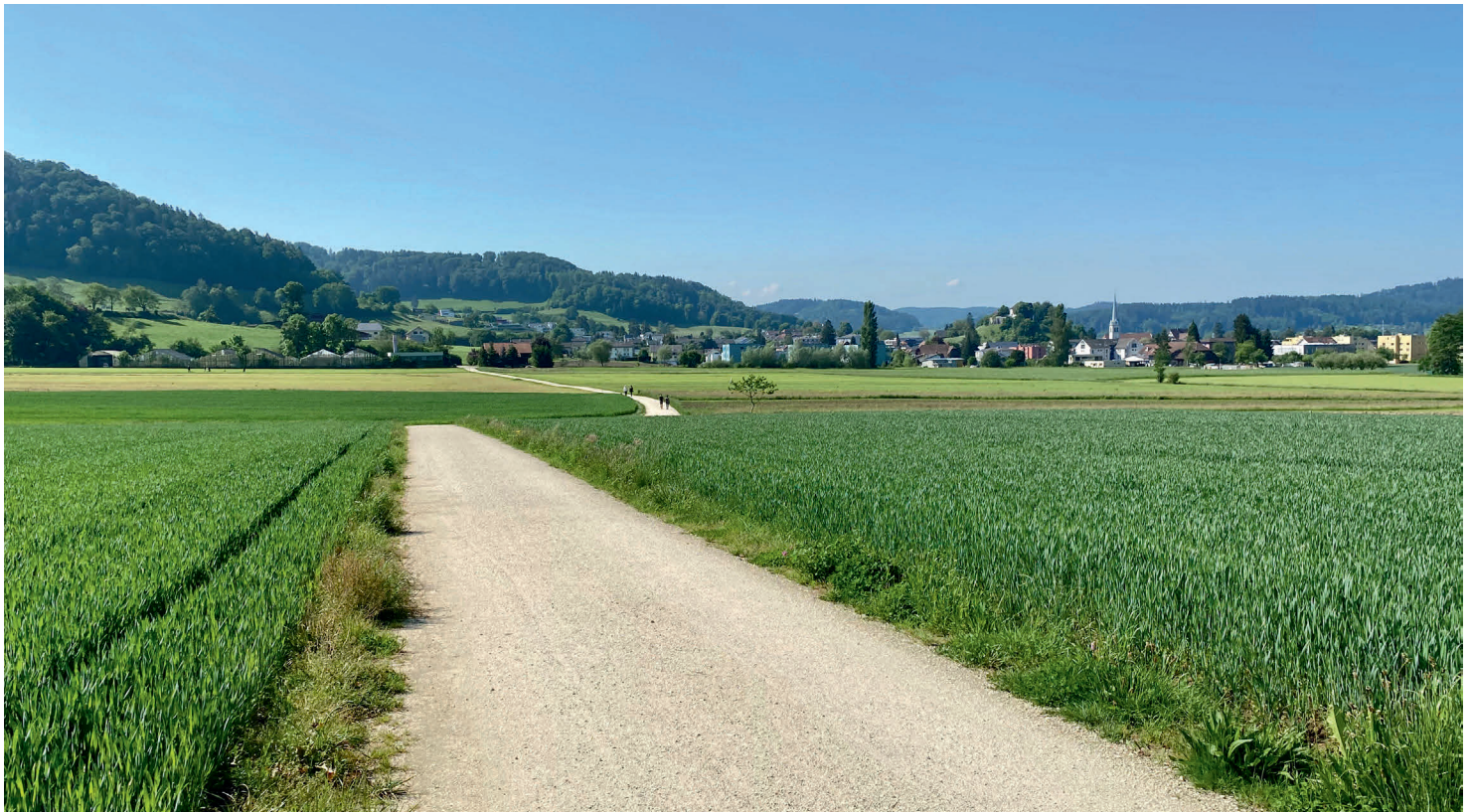
Die Verbindungsstrasse Oberdorf - Renzligen dient nicht nur der Landwirtschaft. Nach kurzer Zeit hat sie sich zu einem beliebten Spazierweg mutiert. Ergänzt wird die das Strassenstück mit einem Trockenbiotop (beim Baum in der Bildmitte), welches einen wichtigen Bestandteil zum Erhalt und zur Förderung der Artenvielfalt wird.
