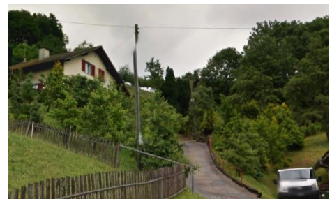
Blick Richtung Liegenschaft Hubelweg 3, Parzelle Nr. 757, GB Reiden; Quelle: Streetview, Zugriff am 29. Juni 2020
