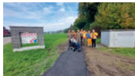
Wegsanierung durch den Zivilschutz
