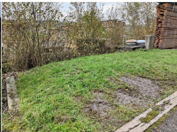
Bereich des bestehenden, rückzubauenden Werkes mit Ziegelbruch im Oberboden
