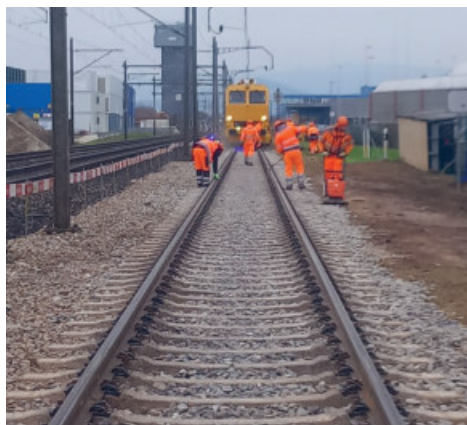
Sanierung Industriegleis Teil 2
