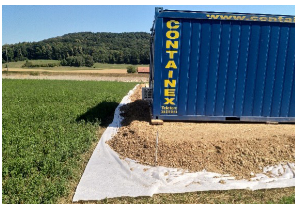
Bodenschutzmassnahmen bei temporären Bauinstallationen
