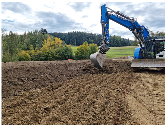
Schichtweiser Bodenauftrag in Streifen (Foto: Dominik Müller)
