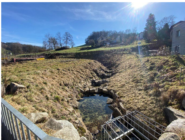
Überblick Projektperimeter, Sertelbach Einlaufbauwerk (Parz. 1426)
