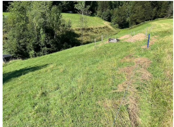
Abb. 4: Einschlagbereich der KD Box Nr. 3 (Sondagen S13, S14).
