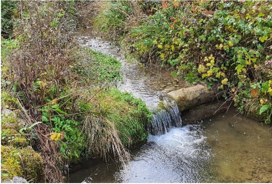
Abbildung 15: Beispiel einer Holzschwelle mit Absturz
