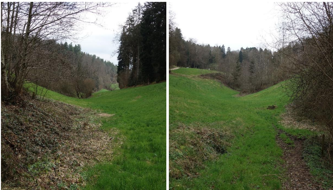
Abbildung 11: links: Eindolung zwischen Waldfläche und offenem Abschnitt, Blickrichtung bachabwärts rechts: Eindolung zwischen Waldfläche und offenem Abschnitt, Blickrichtung bachaufwärts
