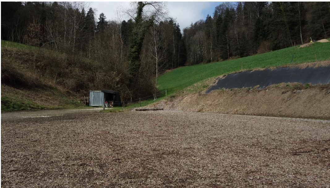
Abbildung 9: Eindolung im Bereich der ehemaligen KD-Box 3
