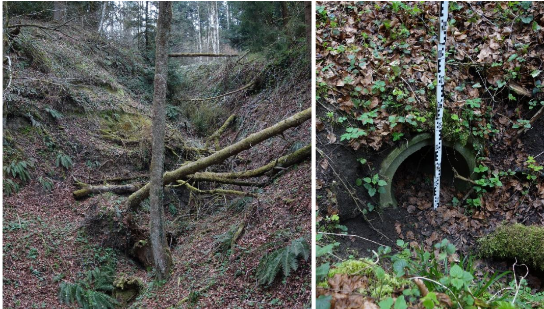
Abbildung 6: links: Tobelstrecke Langnauerwald rechts: Einlauf des Durchlasses zwischen Tobelstrecke und Wiesengraben
