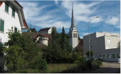
Abb. 23 - Sicht auf historische Bausubstanz.
