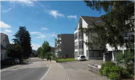
Abb. 34 - Strassenraum mit beidseitigem Trottoir, einer Abfolge von Grossbäumen und ortstypischen Elementen wie Brunnen und Sockelmauern.
