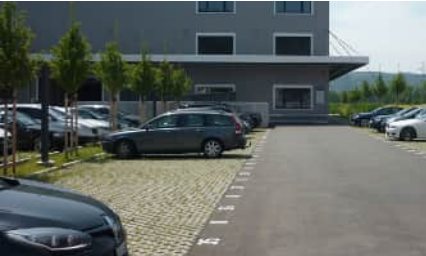
Abb. 50 - Parkplätze mit sickefähigem Belag und Baumreihen.
