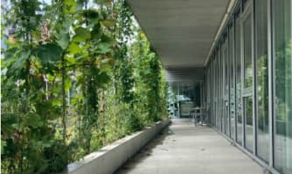
Abb. 47 - Bodengebundene Fassadenbegrünung an Bürogebäude
