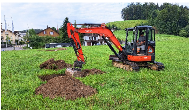
Durchführung Baggerschlitz mit Klein Raupenbagger
