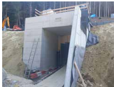
Eingangsbereich Reservoir Huebäbni, Richenthal
